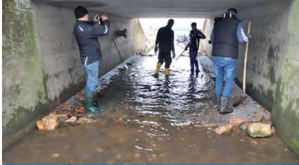
Nach der Installation der Metallgitter im November 2017 unter dem Brückenbauwerk wurden im Rahmen eines Projekttag der HS RheinMain aus Wiesbaden die Zwischenräume mit ortstypischen Sedimenten befüllt. Fotos: Thomas Paulus
