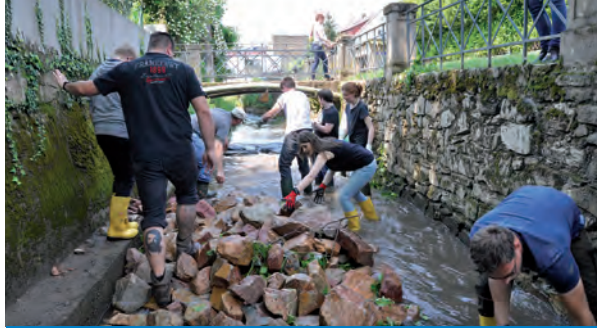
Oberhalb des neuen Benthos-Passes verhindert ein Sohlenabsturz die freie Wanderung der aquatischen Lebewesen. Das angelieferte Steinmaterial wurde per Hand im Rahmen des GN-Tages eingebaut.
