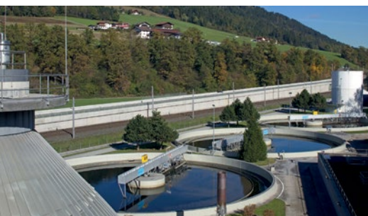
Kläranlage Fritzens, Tirol
