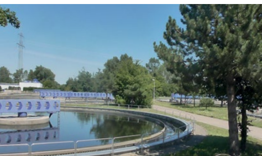
Kläranlage Erdinger Moos
