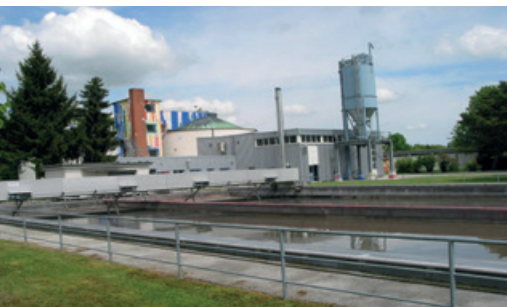
Kläranlage Neuburg a.d. Donau
